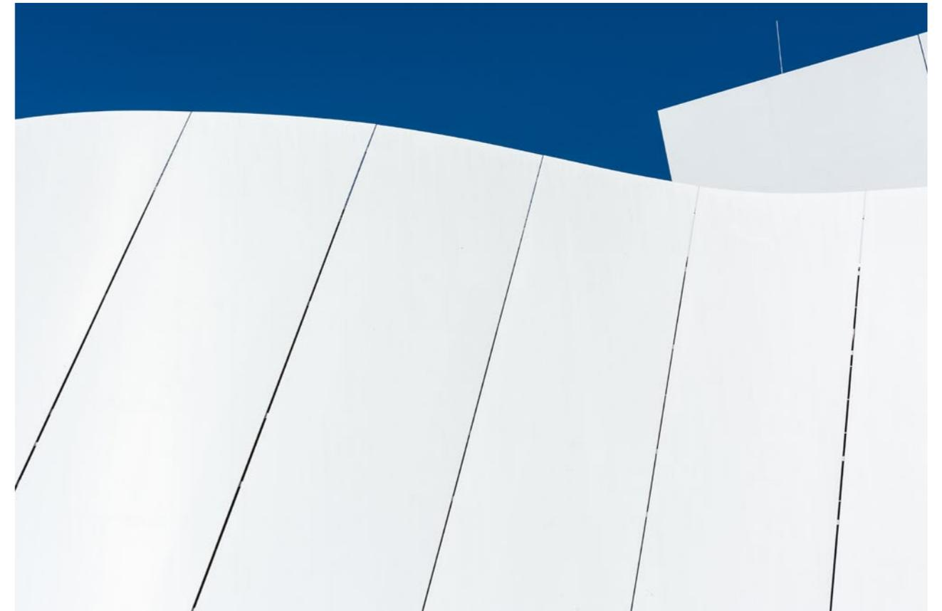
**Ozeaneum** – Der Museumsbau ist eine Stahlbeton- und Stahlverbundkonstruktion. Seine Außenhülle in Form von geschwungenen Bändern besteht aus weiß beschichteten Stahlplatten, wie sie im Schiffsbau verwendet werden. Sie symbolisieren vom Wind geblähte Segel.
